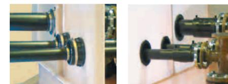
樹脂配管専用の保護部材で施工処理
